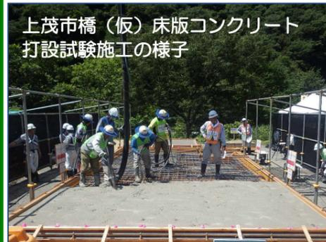
上茂市橋（仮）床版コンクリート打設試験施工の様子
